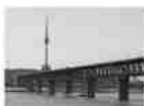
A. 武汉长江大桥
